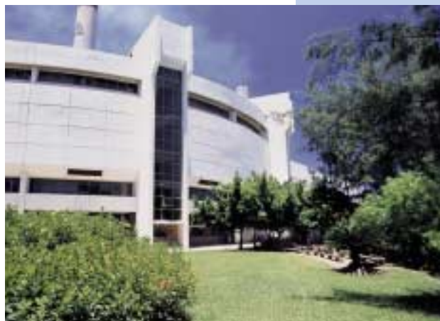
南丫發電廠的行政大樓。
