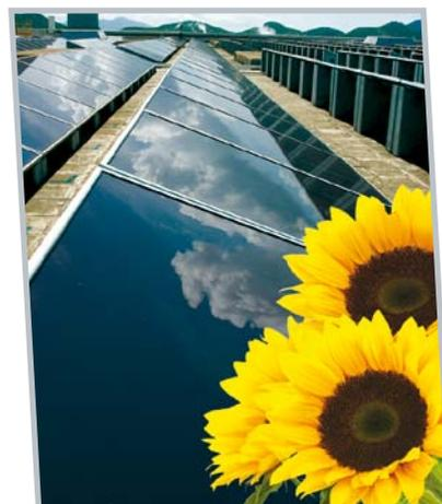
劉先生表示：「我們一直在研究這些薄膜光伏太陽能板，並與傳統的晶體硅太陽能板作比較。我們選擇薄膜太陽能板的原因之一，是生產所需的硅材料較少。反觀需要大量硅材料的傳統太陽能板，由於在製造過程中會耗費大量能源，因此往往要等數年時間，才能從所生產的太陽能電力中彌補製造太陽能板所消耗的能源。傳統太陽能板的回本期大概是三至四年，但我們選用的太陽能板，回本期只需年半；這種太陽能板的設計壽命長達二十年。
